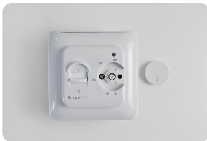
Termostat s demontovaným voličem
